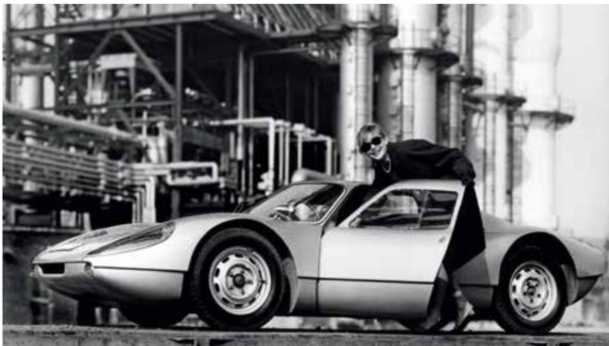
1964年，保時捷新車型 904 Carrera GTS 的外殼使用巴斯夫塑膠 Palatal。
